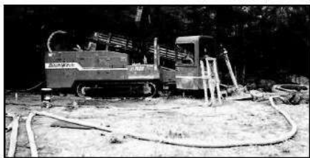
Рисунок 6.17 Прокладка трубопровода методом горизонтально направленного бурения.
