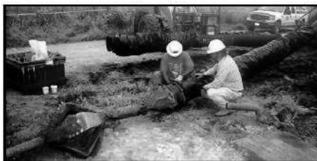
Рисунок 6.17 Прокладка трубопровода методом горизонтально направленного бурения.
