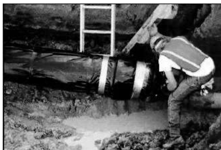
Рисунок 6.22 Покрытие труб полиэтиленовым рукавом.
