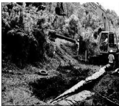
Рисунок 6.24 Картриджный метод укладки труб.
