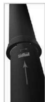
5. Стыковка труб и установка стопоров
