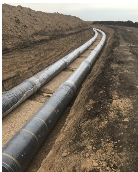
Частичная засыпка трубопровода под гидроиспытания
