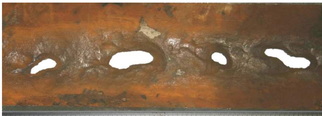
Сквозная коррозия на образце бесшовной трубы 219х9 мм Ст20 после 1 года эксплуатации на нефтесборном коллекторе ООО «РН-Ставропольнефтегаз»
