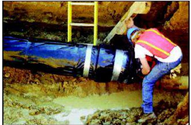
Рисунок 6.22 Покрытие труб полиэтиленовым рукавом.
