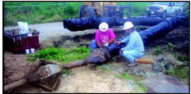
Рисунок 6.17 Прокладка трубопровода методом горизонтально направленного бурения.
